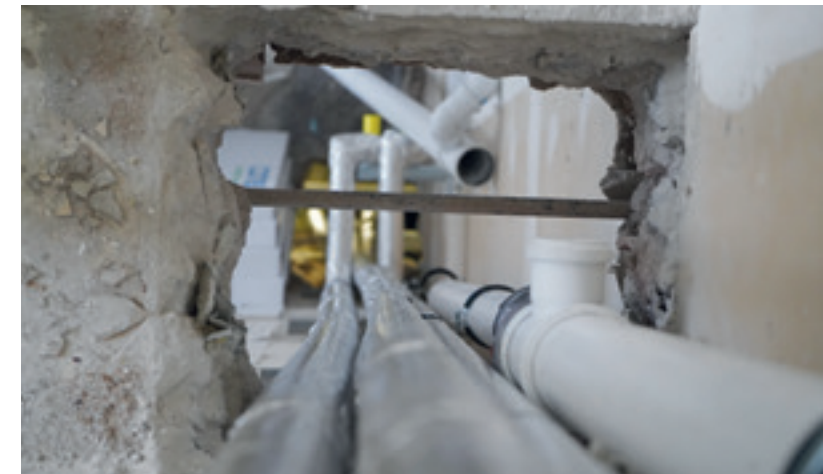
Sanierungsmaßnahmen in Rahlstedt: Neben Elektronik und Zimmerbeleuchtung wurden unter anderem auch die Zu- und Schmutzwasserleitungen erneuert.
